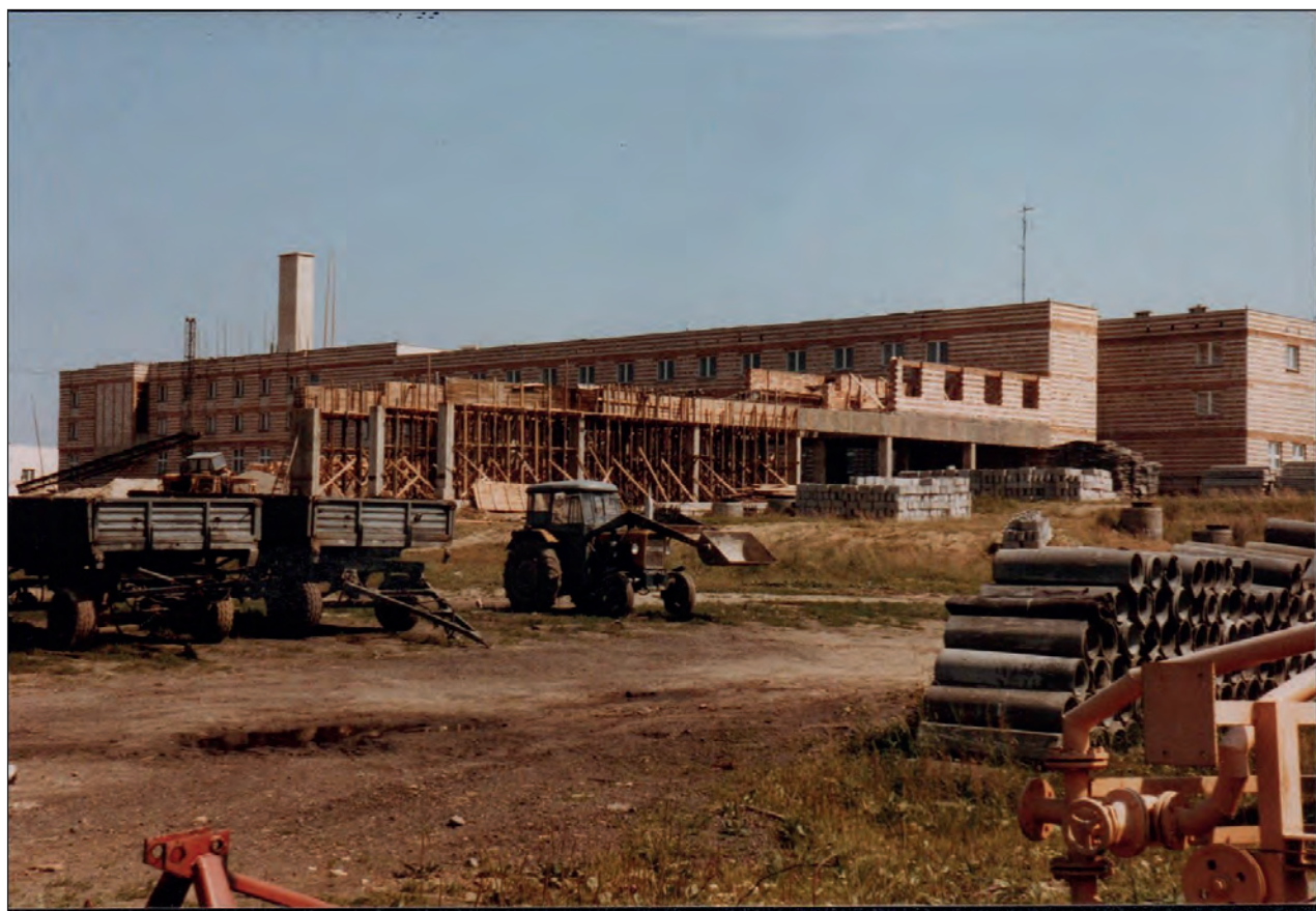
Fot. 16. Budowa Wyższego Seminarium Duchownego Diecezji Koszalińsko-Kołobrzskiej, 1985 r. Źródło: Archiwum Diecezji Koszalińsko-Kołobrzskiej.
