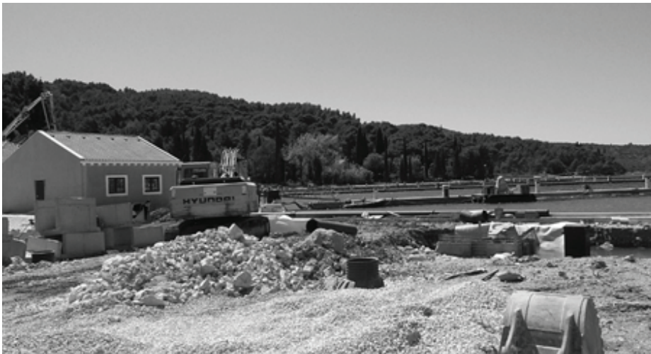
Rysunek 2. Budowa mariny w Slano, kwiecień 2016 r.
