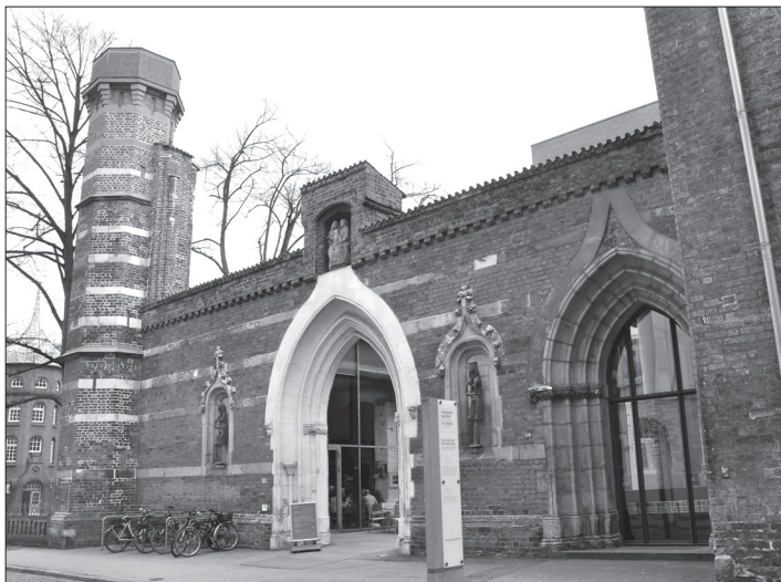
Abbildung 13. Lübeck St. Annen, Ruine der Westfassade der ehem. Stiftskirche
