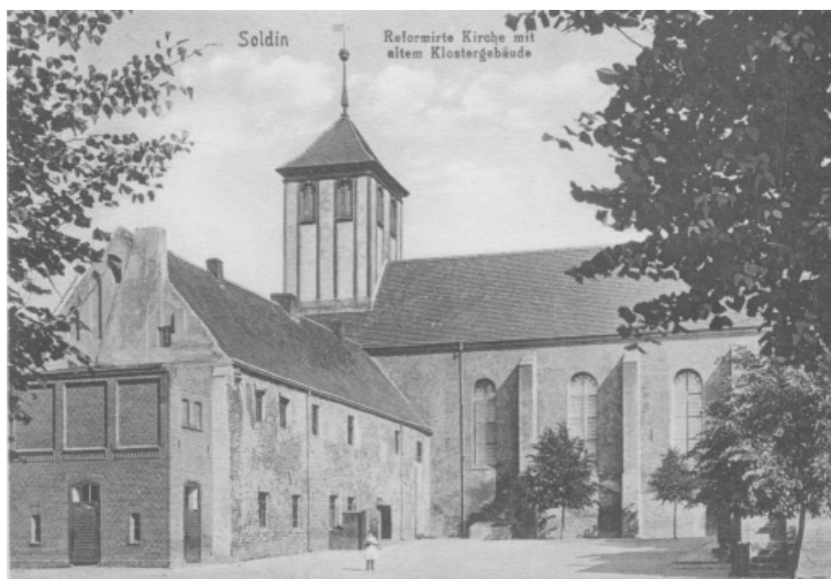
Fot. 1. Widok dziedzińca wewnętrznego przed przebudową (1927/28)
