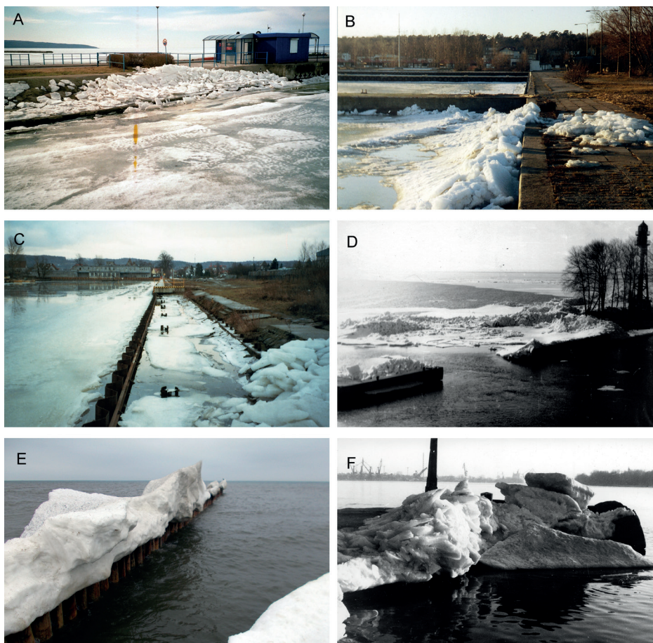
Rys. 2.28. Lód na obiektach hydrotechnicznych na nabrzeżach portów: A – we Fromborku, 16 III 2011; B – w Kryńcy Morskiej, 2 III 1999; C – w Tolkmicku, 11 II 2011; D – na torze wodnym (Brama Torowa I) na Zalewie Szczecińskim, 12 III 1979; E – na ostrogach w Dziwnówku, 19 II 2021; F – na falochronie w Świnoujściu, 18 III 1986
