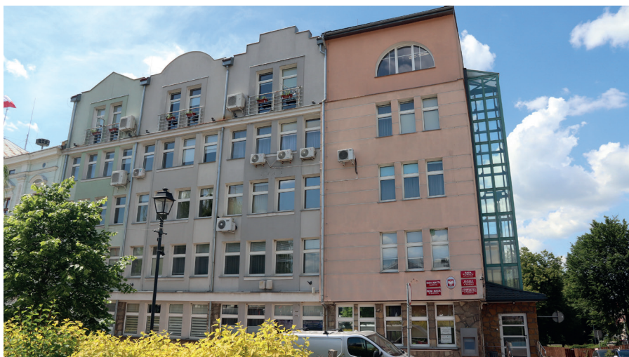
Fot. 8.4. Starostwo Powiatowe w Sanoku i wybrane wydziały Urzędu Miasta w Sanoku – nowe skrzydło budynku dobudowane w latach 60. XX wieku
