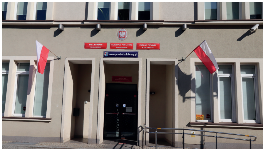
Fot. 14.11. Tablice urzędowe i flagi Polski nad wejściem głównym do Starostwa Powiatowego w Kołobrzegu
