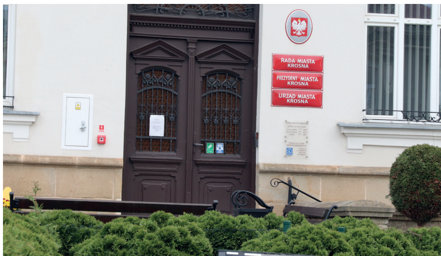
Fot. 4.3. Tablice urzędowe przy wejściu głównym do Urzędu Miasta Krosna
