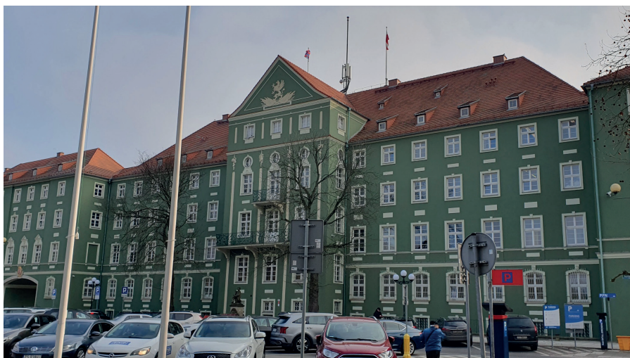
Fot. 19.4. Urząd Miasta Szczecin – zbliżenie na fasadę główną budynku
