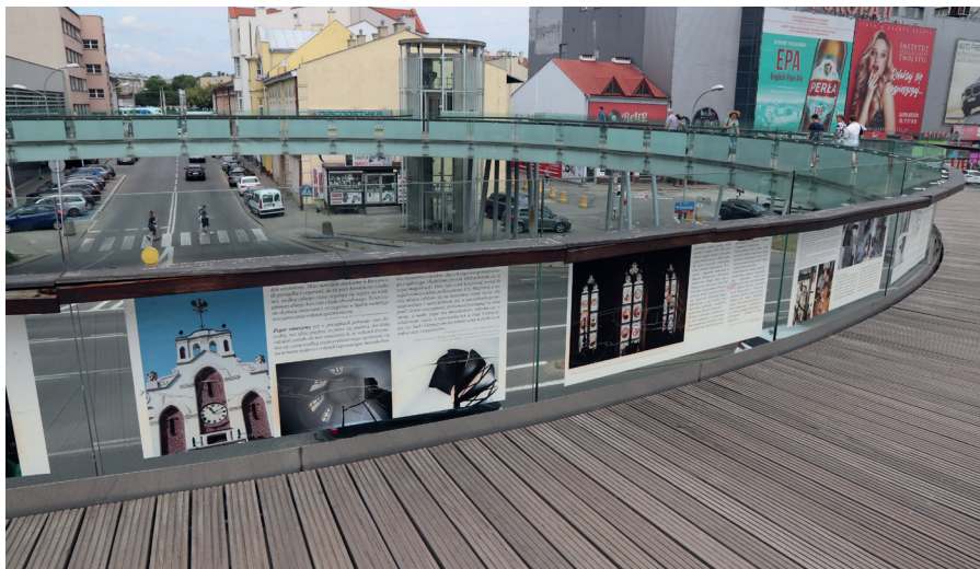
Fot. 7.7. Okrągła Kładka im. WOŚP – jeden z najbardziej rozpoznawalnych punktów miasta, obiekt unikatowy w skali kraju
