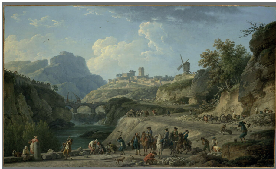
La Construction d'un grand chemin (Budowa drogi).
