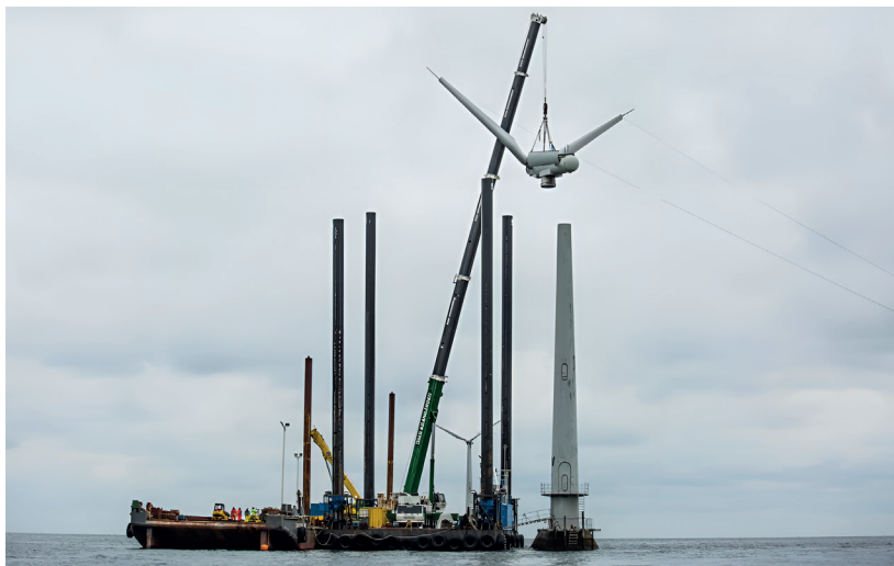
Zdjęcie 3. Demontaż MFW Vindeby w 2017 roku Źródło: materiały prasowe Dong Energy.
