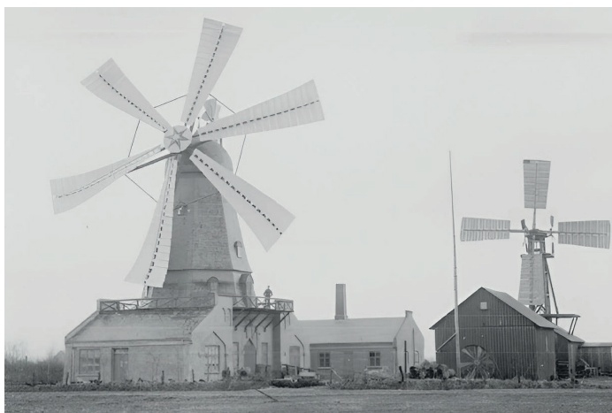
Zdjęcie 2. Elektrownia wiatrowa konstrukcji duńskiego naukowca Poula la Coura z 1889 roku
