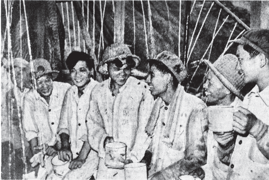
W stalowni w Czungking
